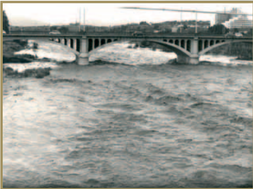
Actuació dels bombers durant la riuada del Francolí de l'11 d'octubre de 1970. Fotos: Chinchilla. Sig. 4345 i 4342.
