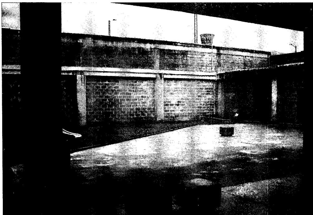
Patio de Visitas Establecimiento Penitenciario y Carcelario de Mediana seguridad de Acacías
