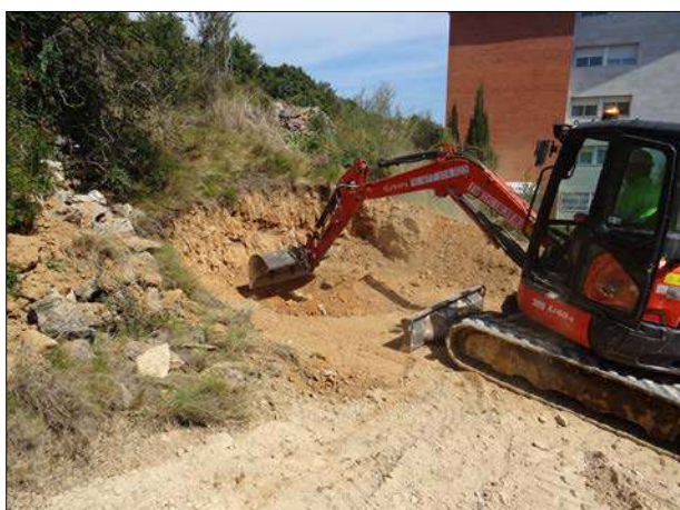
Figura 43 | Excavació de la rasa 11.
