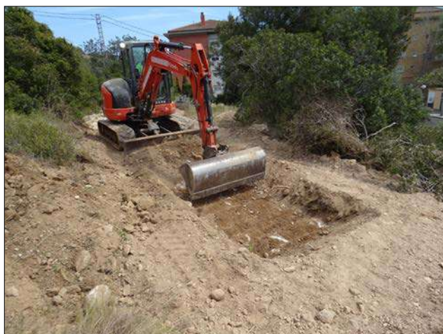
Figura 41 | Excavació mecànica de la rasa 10.
