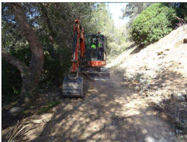
Figura 37| Excavació mecànica de la rasa 8.
