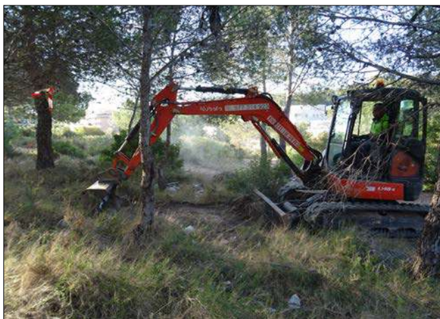
Figura 2| Excavació mecànica de la rasa 1.
