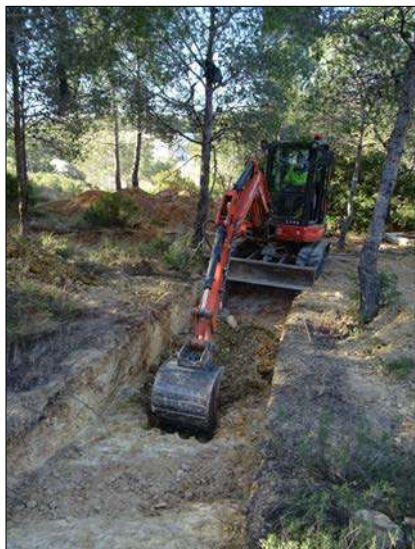
Figura 10| Excavació de la cala.
