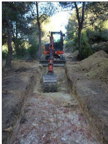
Figura 33| Excavació de la rasa 7.
