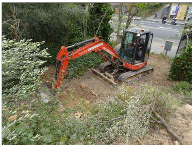
Figura 48| Excavació mecànica de la rasa 13.
