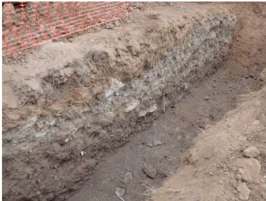
Fig.37 | Abocaments de materials de rebuig provinents de la urbanització del sector Vall de l'Arrabassada.
