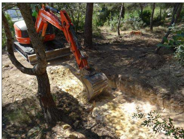
Figura 26 Excavació mecànica de la rasa 5.
