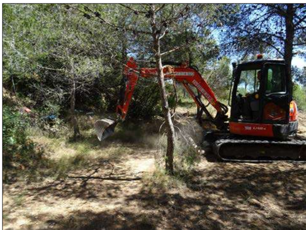
Figura 29 | Excavació mecànica de la rasa 6.
