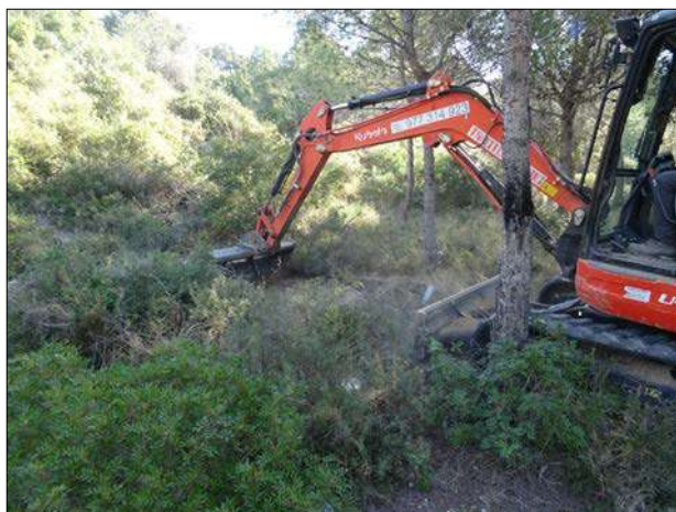
Figura 8 | Excavació mecànica de la rasa 2.
