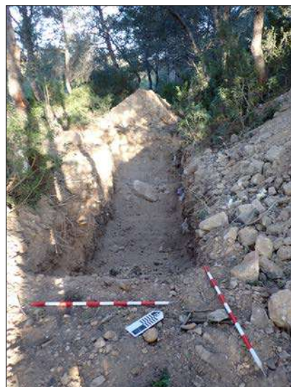
Figura 40 Gran abocament de materials de rebuig de les obres de construcció de la urbanització Vall de l'Arrabassada.
