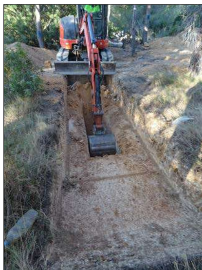
Figura 4| Excavació de la cala.
