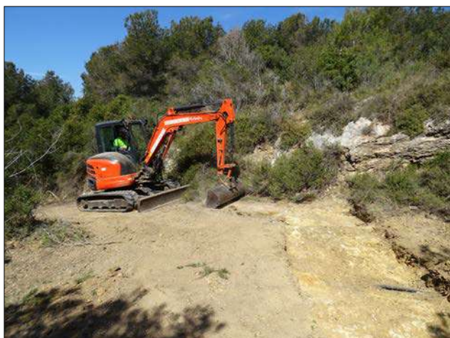
Figura 21 | Excavació mecànica de la rasa 4.
