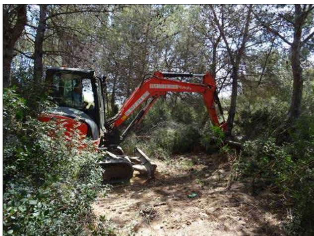
Figura 39 Excavació de la rasa 9.
