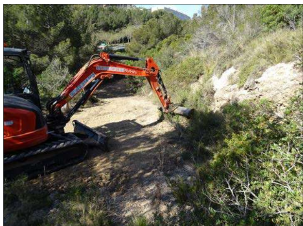
Figura 14 | Excavació mecànica de la rasa 3.
