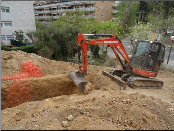
Figura 46| Excavació mecànica de la rasa 12.
