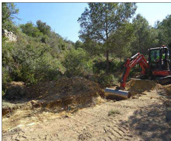
Figura 16 | Excavació de la rasa 3.
