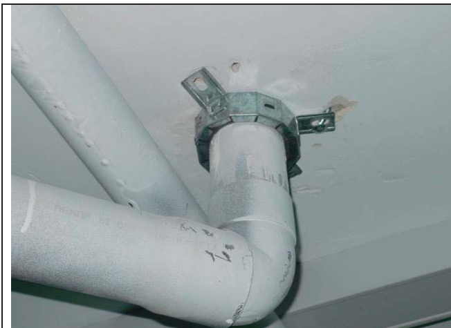
FOTO EJEMPLO ANILLO INTUMESCENTE PARA SELLAR EL HUECO EN CASO DE INCENDIO
