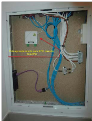
Foto exemple roseta per a 2 fibres connector SC / APC
