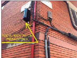
FOTO EXEMPLE XARXA ALIMENTACIÓ FIBRA ÒPTICA RESPONSABILITAT DEL OPERADOR
