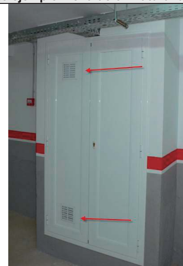
Foto ejemplo: ventilación natural directa
