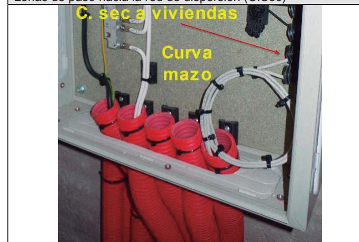
Foto ejemplo acometidas en los registros secundarios como zonas de paso hacia la red de dispersión (C.Sec)
