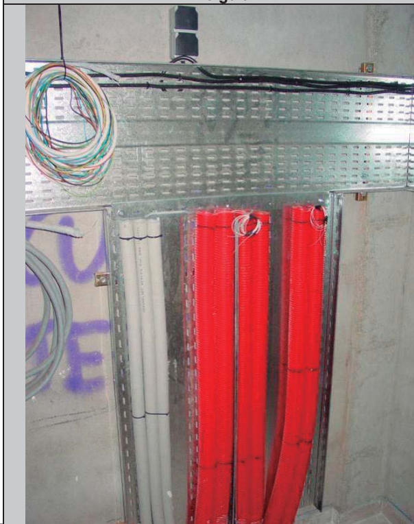
Se muestra una foto ejemplo de tubos ocupados con hilo guía
