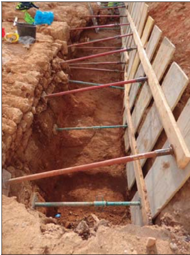
Figura 21 | Vista del sector 5 un cop instal·lat l'apuntalament del perfil NE. A l'esquerra, mur d'espona medieval 1082.
