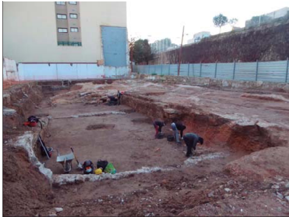
Foto 1. Vista general del solar abans d'iniciar els treballs.
