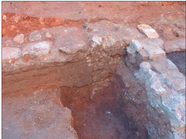
Foto 9. Vista del punt d'unió entre els murs 1007 i 1068.
