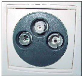
FOTO EXEMPLE BAT R-TV-SAT TRIPLE, INTERIOR VIVIENDAS
