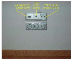
FOTO EXEMPLE CONJUNT PRESSES TELECOMUNICACIONS EN SALÓ
