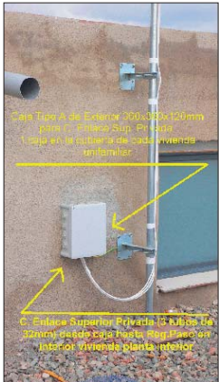
CAIXA EXTERIOR TIPUS-A
