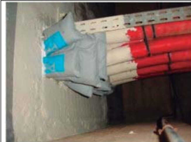
FOTO EJEMPLO SACOS INTUMESCENTE PARA SELLAR EL HUECO EN CASO DE INCENDIO
