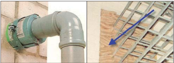
FOTO EJEMPLO INSTAL·LACIÓ MANIGUETS INTUMESCENTS
