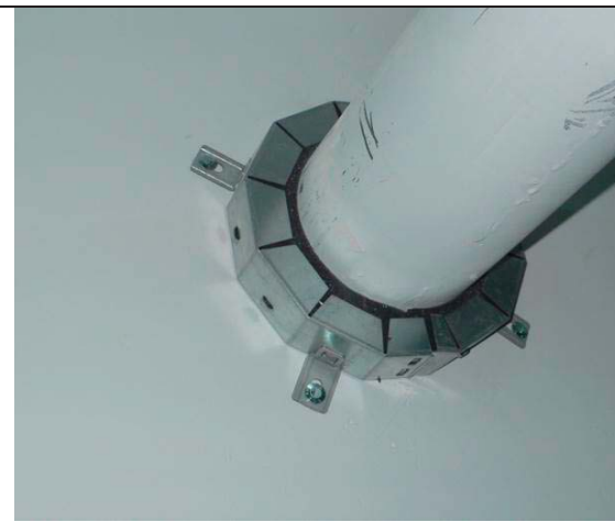
FOTO EJEMPLO ANILLO INTUMESCENTE PARA SELLAR EL HUECO EN CASO DE INCENDIO
