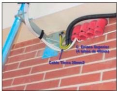
FOTO EXEMPLE CABLE DE TERRA 25MM
