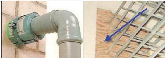
FOTO EXEMPLE INSTAL·LACIÓ MANIGUETS INTUMESCENTS
