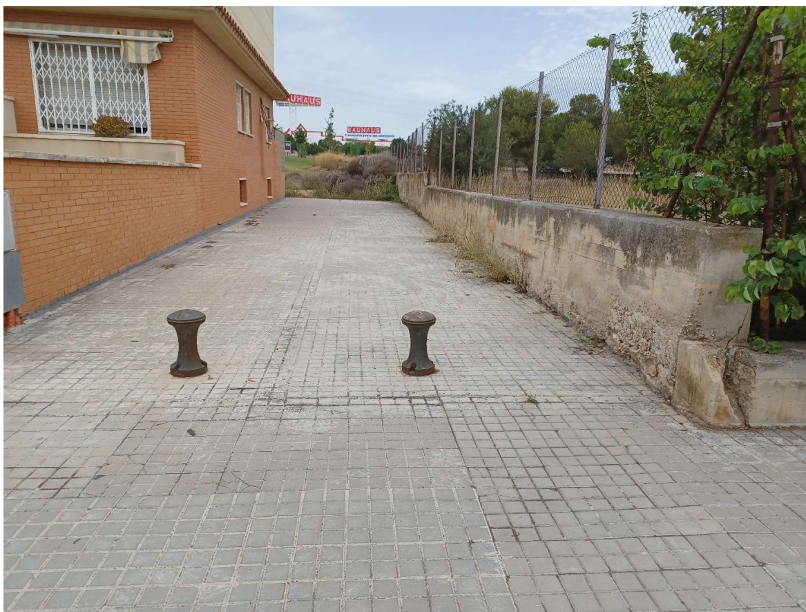
FOTO Nº 9: Punt on el traçat de la canonada passarà de ser en rasa de terres a rasa en calçada de amb el paviment de titularitat privada.
