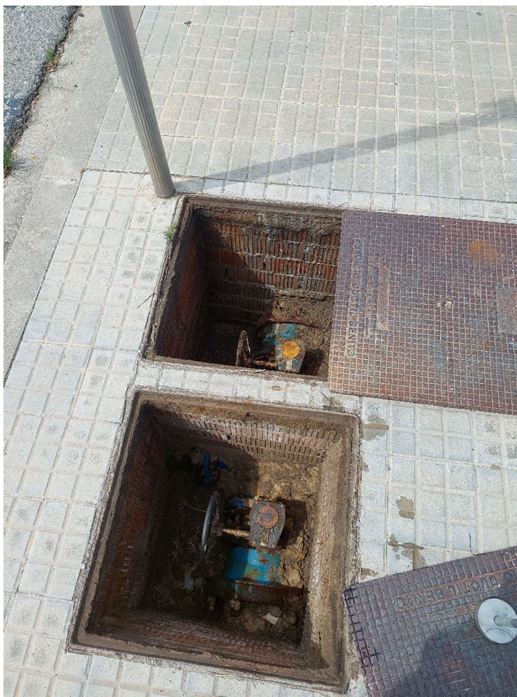
FOTO Nº 4: Vista d'alguns dels serveis existents als voltants de la zona d'actuació, inclòs d'algunes de les rases que creuen actualment la calçada.
