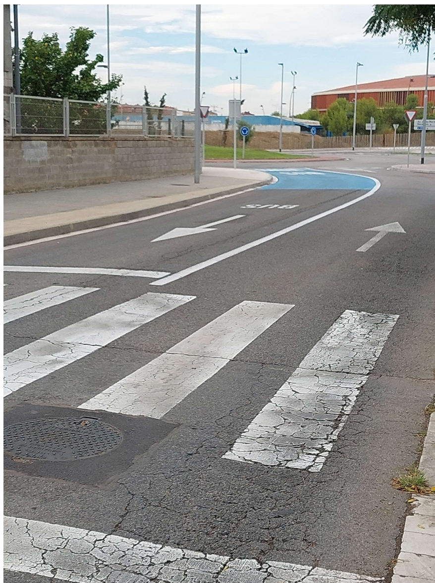
FOTO Nº 14: Vista del punt on finalitzarà un dels dos punts de connexió, del punt on es connectarà la canonada d'aigua existent de fosa dúctil de 450 mm de diàmetre a la nova canonada també de fosa dúctil de 400 mm de diàmetre.
