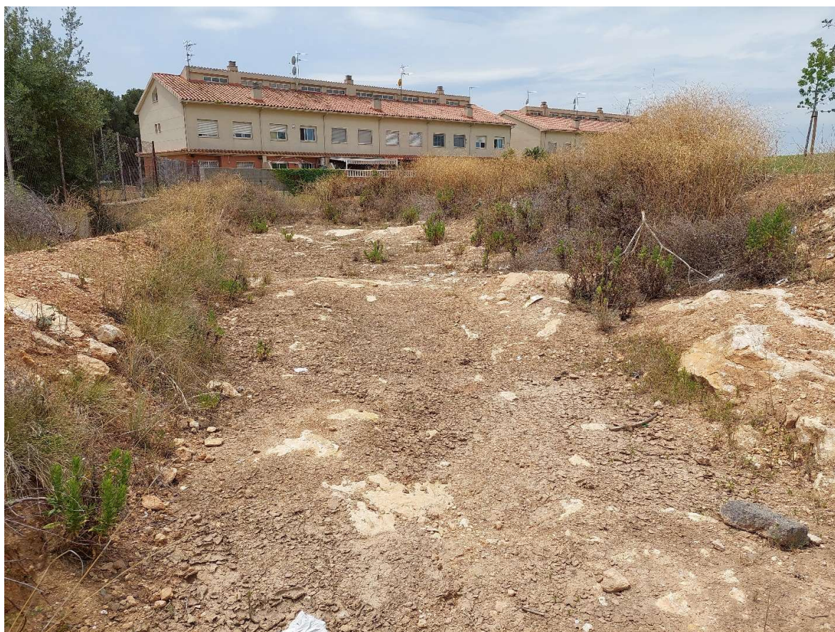
FOTO Nº 8: Tram de la canonada en rasa de terres.
