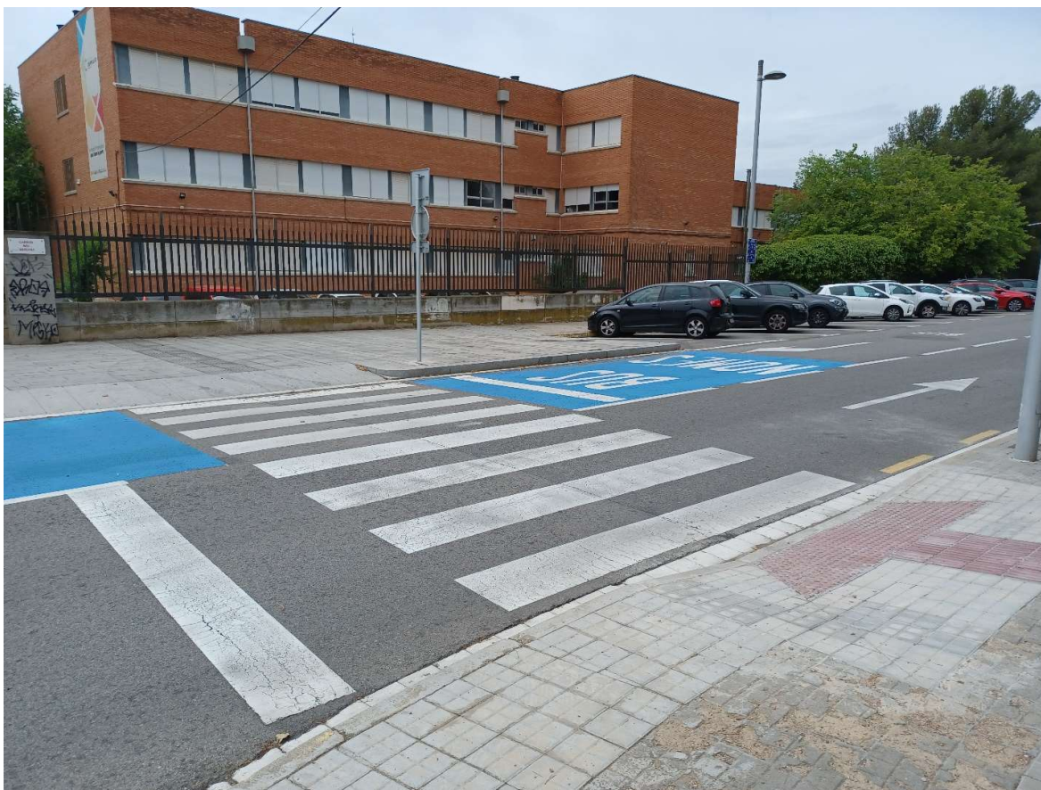
FOTO Nº 10: Vista de la zona on anirà el segon tram del traçat de la canonada d'abastamentdirecció Rambla de Ponent a Camp Clar.
