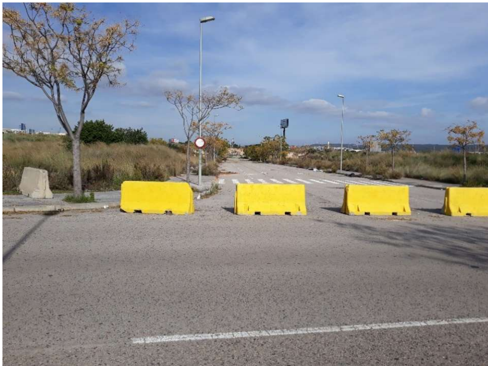
FOTO Nº 1: Vista de la zona on començarà l'obra, i del punt on es connectarà la canonada d'aigua existent de fosa dúctil de 450 mm de diàmetre a la nova canonada també de fosa dúctil de 400 mm de diàmetre.
