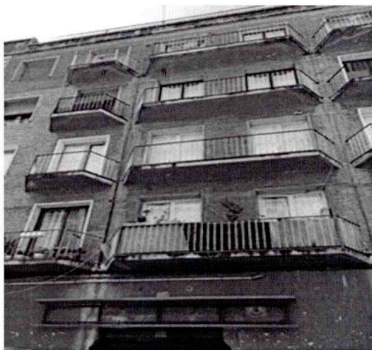
Un dels blocs d'habitatges ocupats al carrer Apocada.
