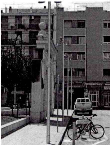
Estat de deteriorament de l'arc De Muller.
