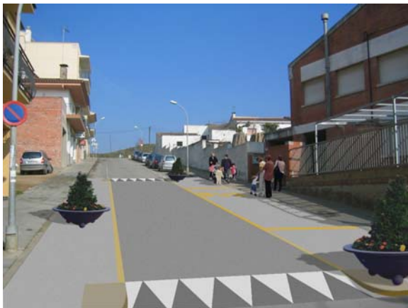
Plataforma sobreelevada que cobreixi tot l'entorn d'accés a l'escola i que inclogui parada de transport col·lectiu i diferents elements de mobiliari urbà.
