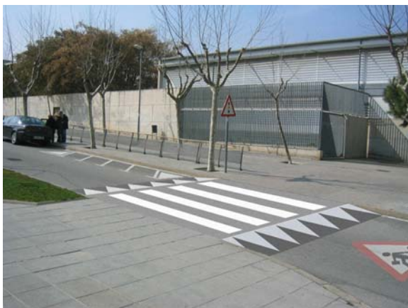
Pas de vianants elevat i senyalització horitzontal.
