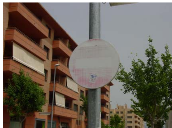
Senyal en estat deficient
