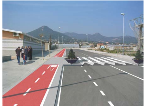
Construcció d'un carril de bicicletes i ampliació de la vorera creant un atri.
