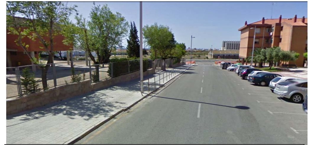
la tanca existent protegeix, de manera correcta, l'accés al centre escolar
