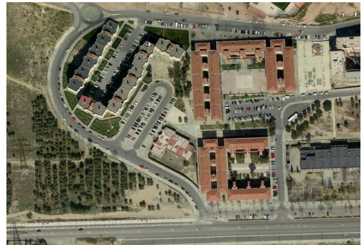
Aparcament a prop de la CN 340 (aprox. 100 vhc.)
