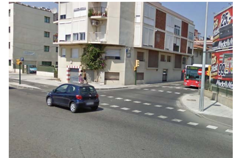
Enllaç del carrer Montblanc amb la N-340
