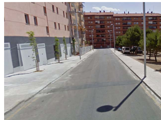
La falta de senyalització vertical i, especialment, horitzontal és un defecte comú a gran part del barri
