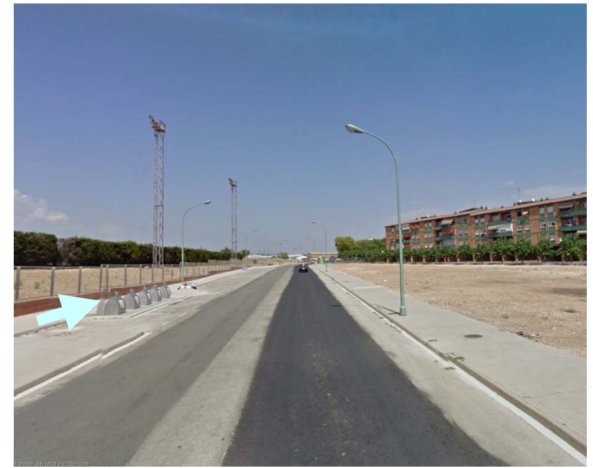
Situació dels contenidors soterrats
