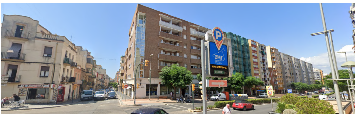
Fig 36. Fotografía de la zona AQN2
