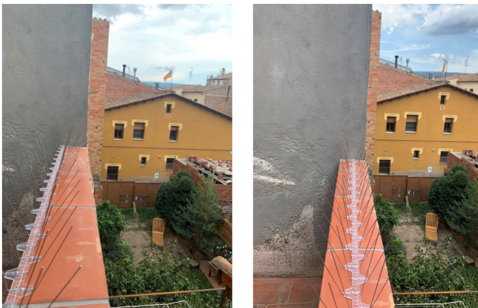
Exemple de pues antiaius mal col·locades (esquerra) i ben col·locades (dreta)
