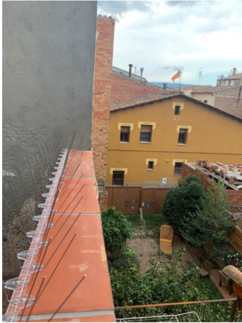
Exemple de pues antiaius mal col·locades (esquerra) i ben col·locades (dreta)
