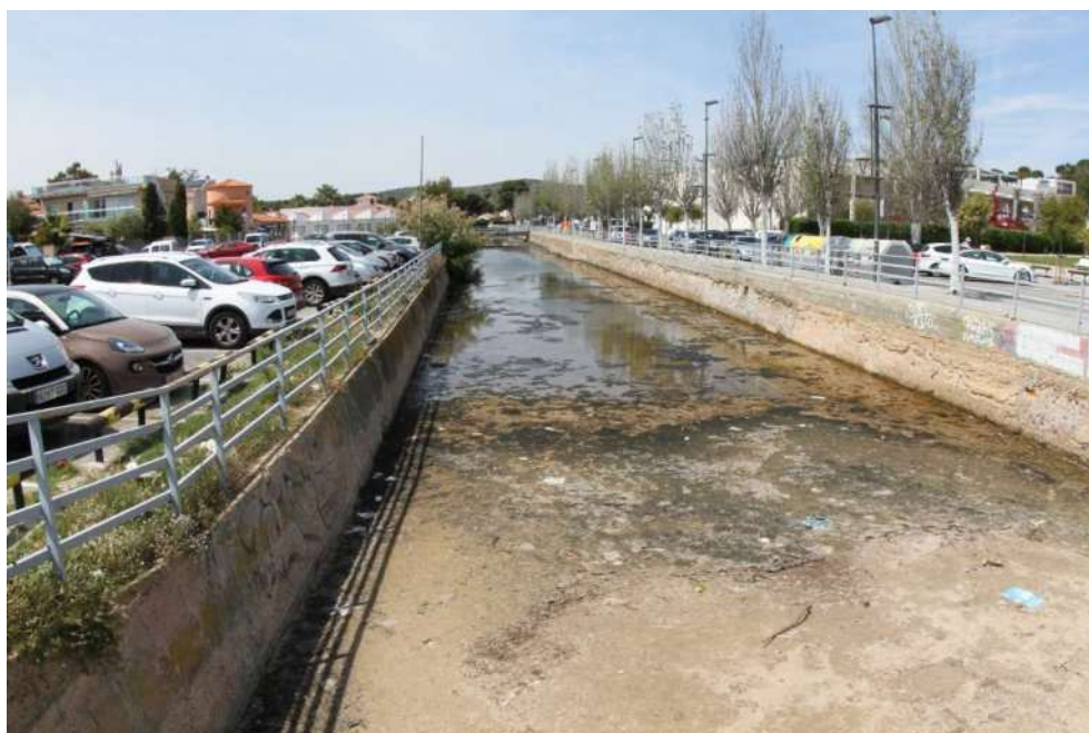
Foto. Tram final, canalitzat, del torrent de la Mora. Foto: @Eduardo Soler
