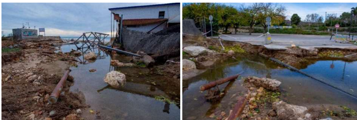
Fotos. Efectes destructius de l'aiguat de Santa Tecla de 2022 a la desembocadura del torrent de la Bassa Closa a la platja Llarga, amb destrucció d'infraestructures i edificis. Font: ©Ferran Aguilar
