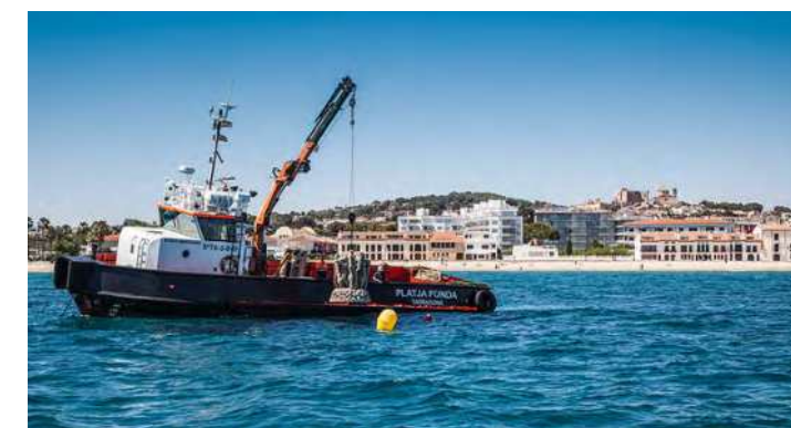
Implantació d'estructures carbonatades mitjançant vaixell i grua.
