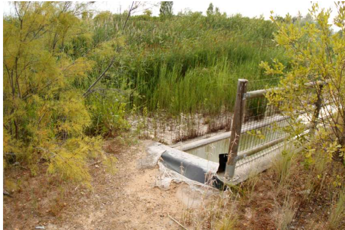
Foto. Estructura d'entrada d'aigües pluvials a la llacuna.
