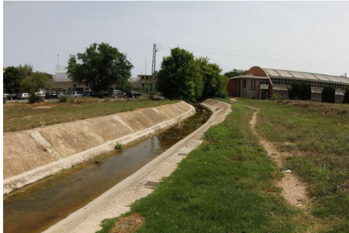
Foto. Tram canalitzat del riu Clar en l'àmbit d'estudi, mirant cap al sud. Al fons a la dreta, instal·lacions esportives municipals.
