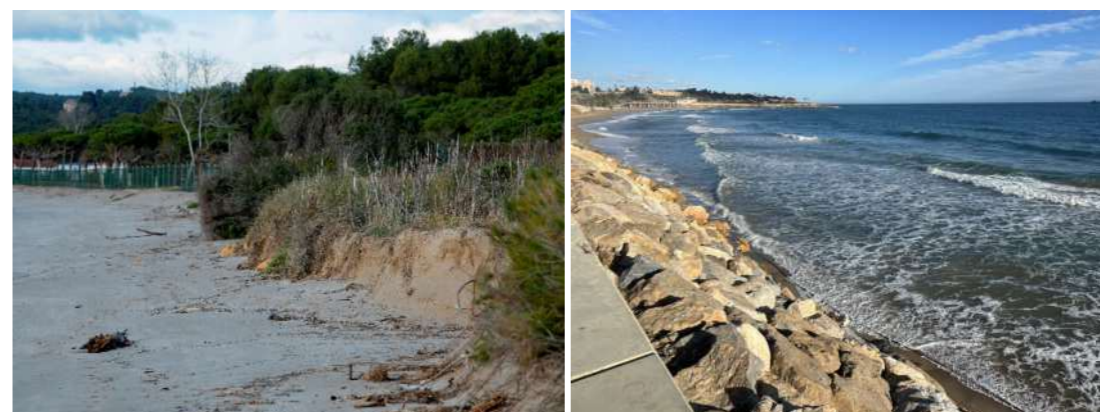
Fotos. A l'esquerra, tram final (oriental) de les dunes de la platja Llarga completament erosionat. A la dreta, onades trencant directament sobre l'escullera a la part occidental de la platja del Miracle. Font: ©Eduardo Soler
