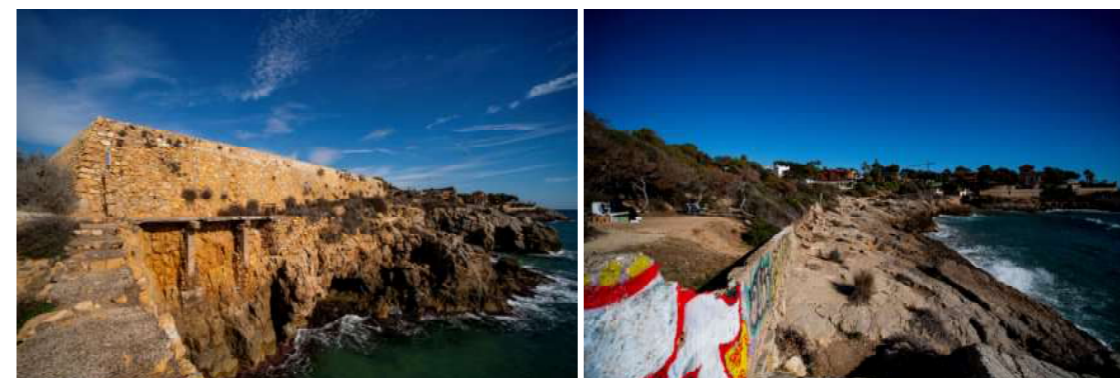
Foto. Façana de mar del Fortí de la Reina; a l'esquerra, mur obsolet de separació del parc de mas Rosselló del roquer litoral. Font: ©Ferran Aguilar
