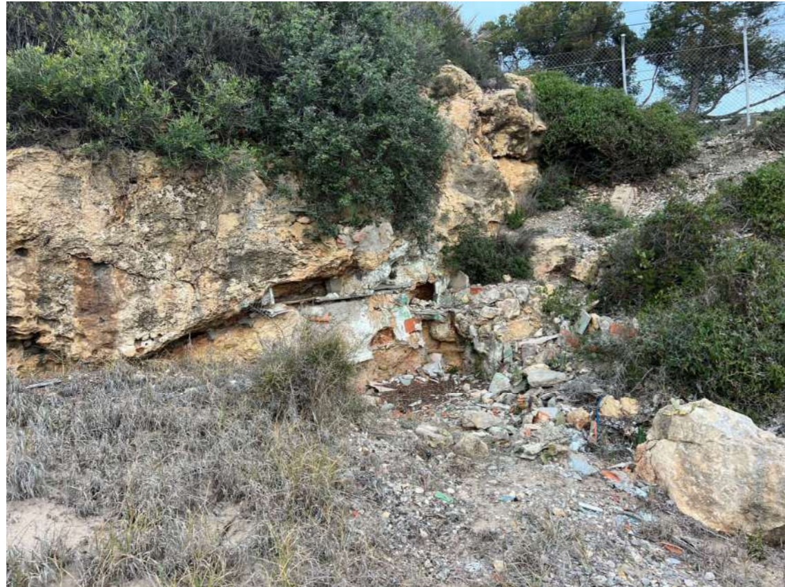
Foto. Petites acumulacions de runa i construccions obsoletes a la reraplatja de la Platja Llarga, dins el perímetre de protecció dunar, que seran eliminats. Font: ©Eduardo Soler
