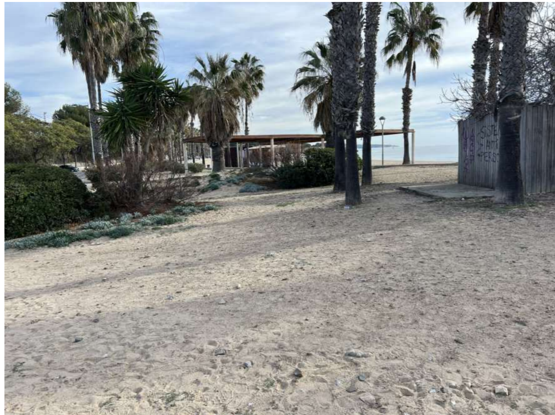
Fotos. Explanades de sorra, sense cap tipus de vegetació, al passeig de l'Arrabassada, on es pensen crear jardineres amb vegetació autòctona. Font: ©Eduardo Soler
