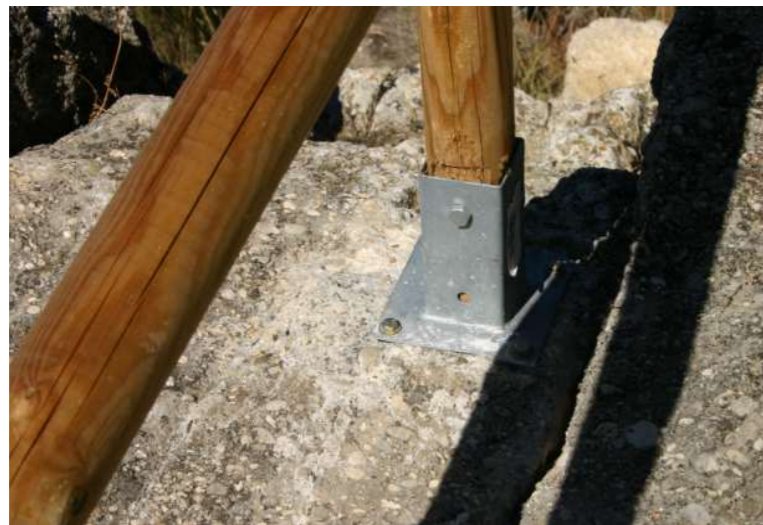
Figura. Detall d'ancoratge de la tanca de fusta amb doble travessera horitzontal sobre substrat rocós
