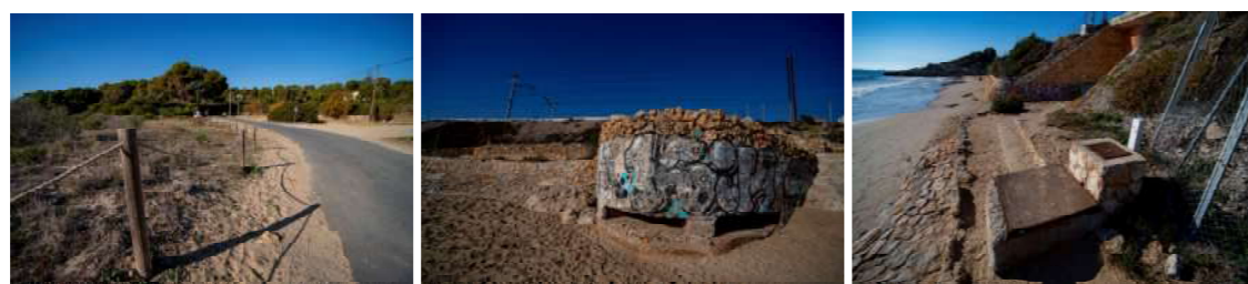
Fotos. Algunes de les construccions que es poden trobar a la Platja Llarga: pista asfaltada d'accés als apartaments, búnquer i banquetes sobre escollera amb serveis. Font: ©Ferran Aguilar
