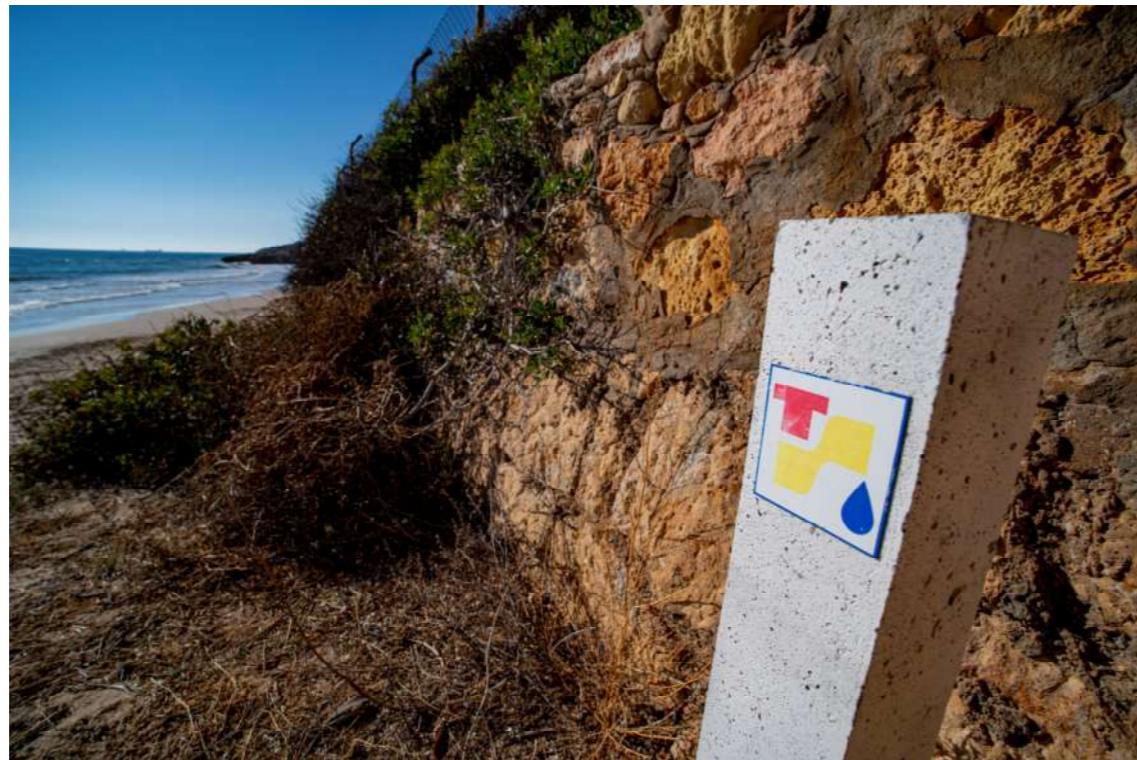
Fotos. Algunes de les estructures que, actualment, ocupen l'àmbit dunar de ponent de la platja Llarga. Sota, fita d'EMATSA, ja que hi recorren serveis de clavegueram i de bombament d'aigües residuals
