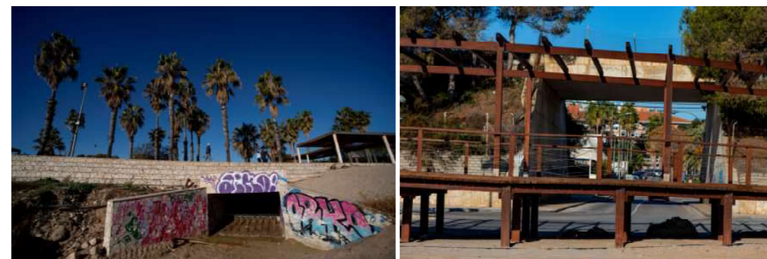
Fotos. Respectivament, sortida dels drenatges que desemboquen a la platja de l'Arrabassada. Font: ©Ferran Aguilar
