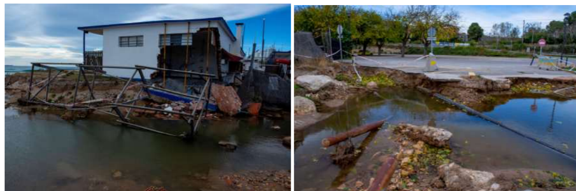
Fotos. Vista de detall de l'edifici del Club Marítim afectat i, a la dreta, excavació del terreny superada la pista asfaltada
