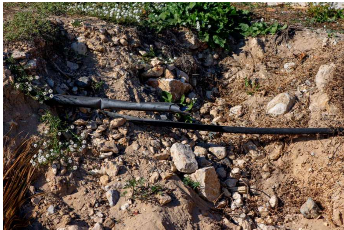
Fotos. Zona de desguàs a la platja de l'Arrabassada amb els talussos mol erosionats.
