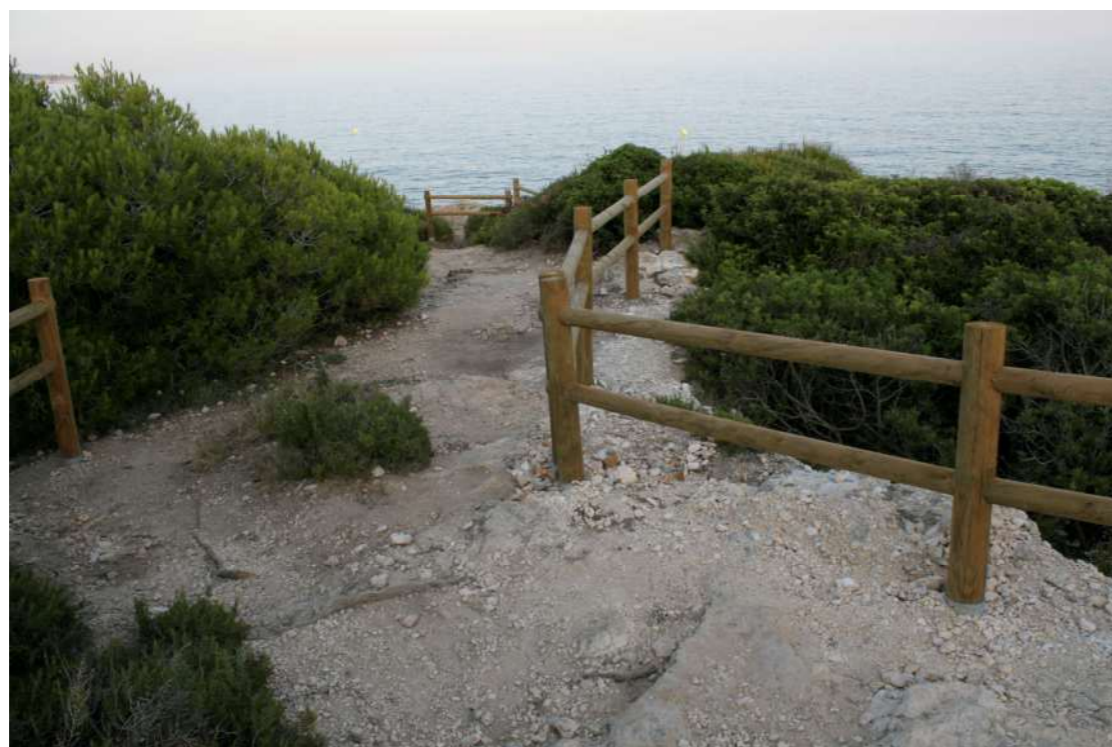
Fotos. Imatges de tram de camí delimitat amb tanca de fusta amb doble travessera horitzontal al roquer de la platja de la Savinosa a Tarragona. Font: ©Eduardo Soler
