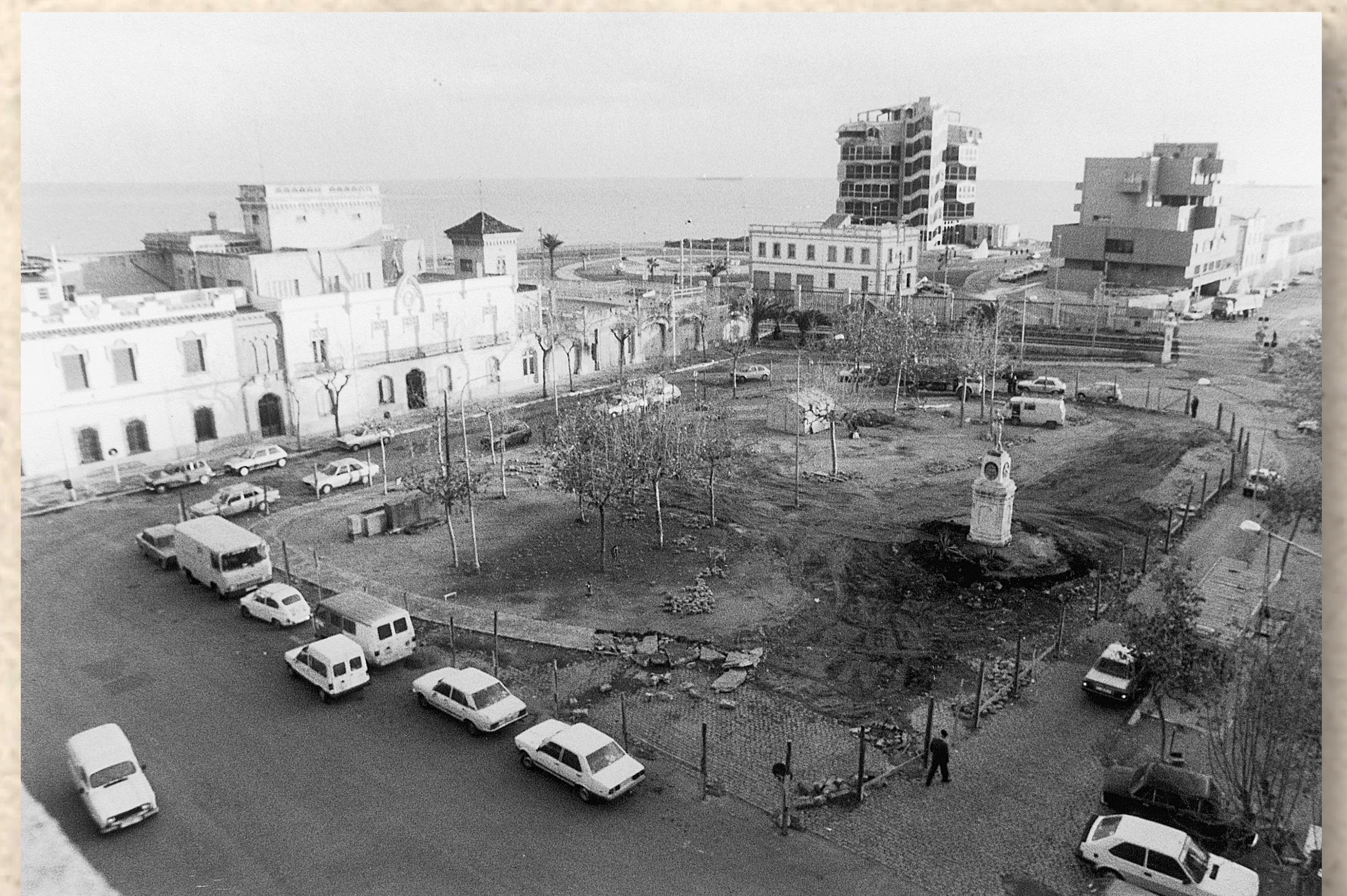
Inici de les obres de remodelació de la Plaça dels Carros, any 1987. CIT / L'Arxiu
