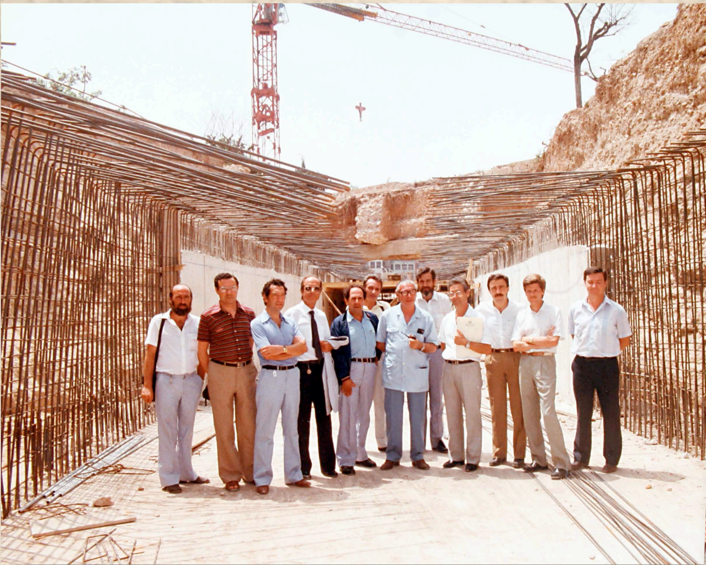
Visita a les obres de construcció de l'Aparcament Municipal de Saavedra, 21 de juliol de 1983. Foto Chinchilla, CIT / L'Arxiu
