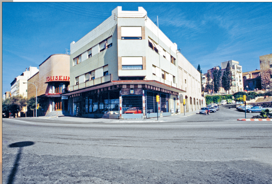
Garatge Panadès i Cinema Coliseum abans de ser enderrocats. Foto Anton Roca, 1985
