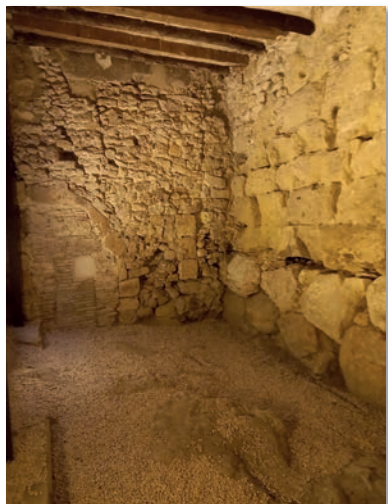
Cara interior del mur extern de la muralla reformat i reaprofitat a la planta baixa de la Casa Canals.
