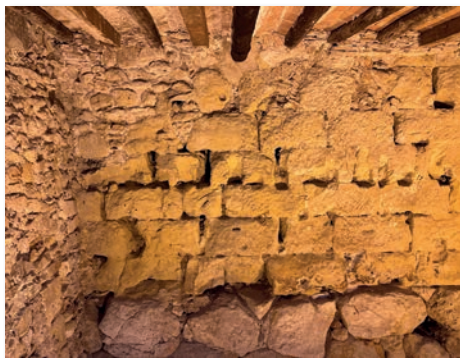
Cara interior del mur extern de la muralla reformat i reaprofitat a la planta baixa de la Casa Canals.
