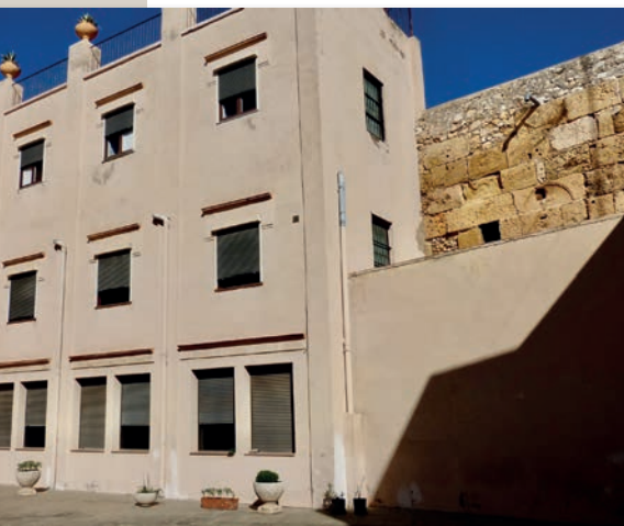
Pati interior del convent de les Oblates on es pot apreciar com l'edifici s'encavalca a la muralla. Foto: Ramon Aloguín.
