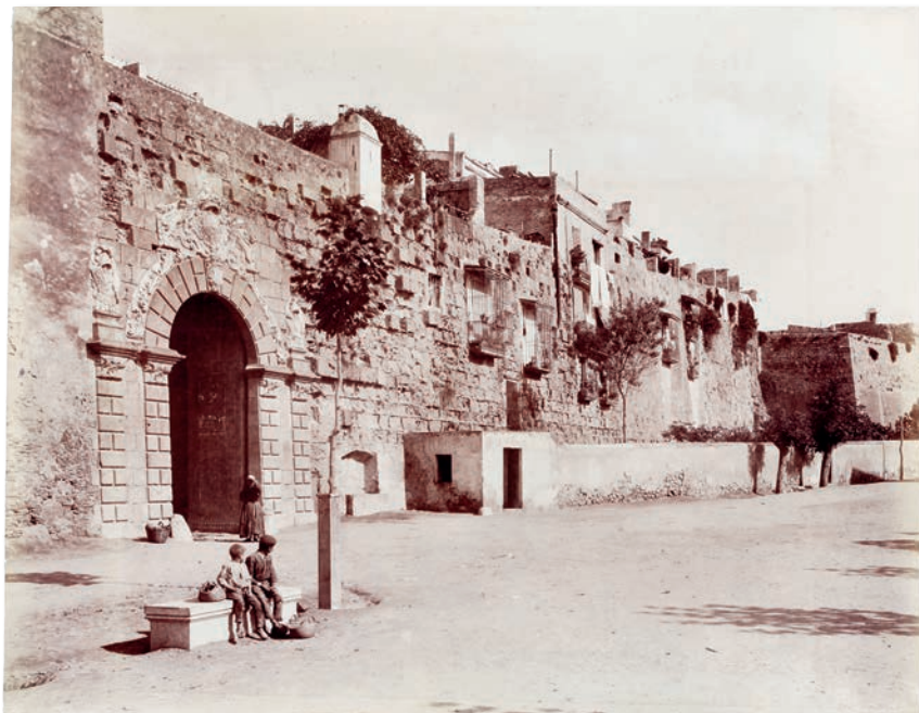
Obertures de finestres i balcons a la muralla al passeig de Sant Antoni.
