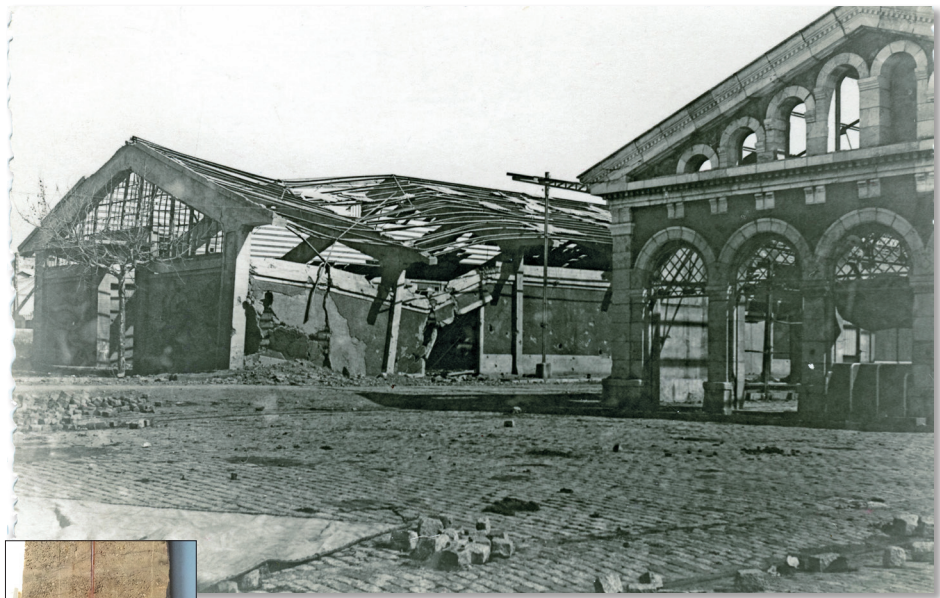
Desperfectes ocasionats pels bombardejos al Moll de Costa. Autor desconegut. l'Arxiu del Port de Tarragona, 1939
