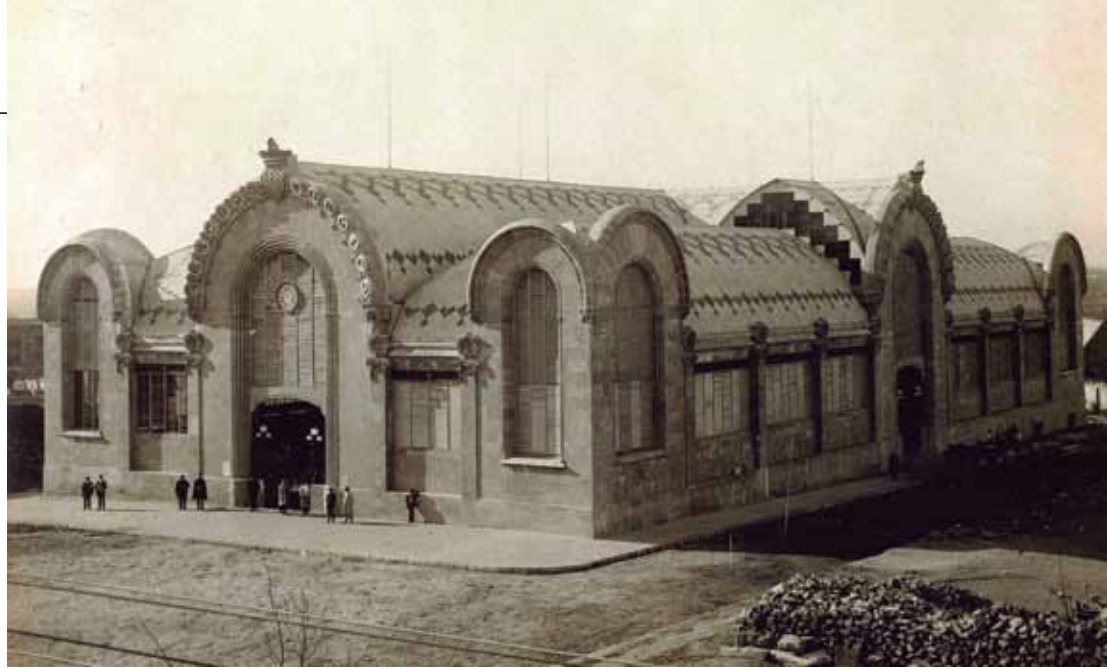
IMATGE DEL MERCAT CENTRAL DE LA PLAÇA CORSINI, ANY 1916. | FOTOGRAFIA: P. PALLEJÀ. CENTRE D'IMATGES DE TARRAGONA / L'ARXIU
