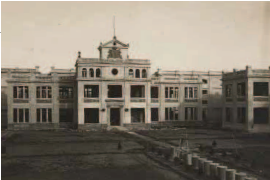
FAÇANA DE L'EDIFICI PRINCIPAL EN CONSTRUCCIÓ, L'ANY 1927. | FOTOGRAFIA D'AUTOR DESCONEGUT. CENTRE D'IMATGES DE TARRAGONA | L'ARXIU.
