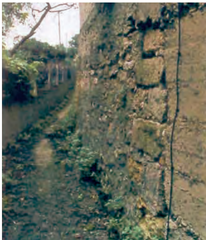
5. Vista parcial del mur del baluard nord i del camí de servitud actual situat al fossat del Fortí.
