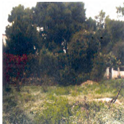
22. Continuació del mur cara sud cobert de vegetació.
