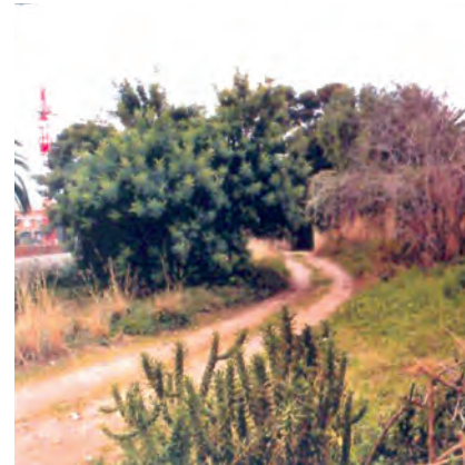
19. Vista del mur oriental del baluard sud, cobert per figueres de moro, abans de l'enderroc.
