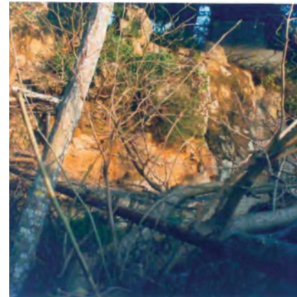
11. Extrem oest del Fortí: mur amb merlets.
