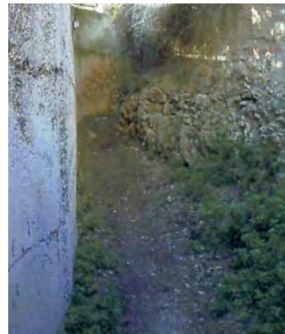
7. Camí de servitud dins del fossat que envoltava el baluard nord.
