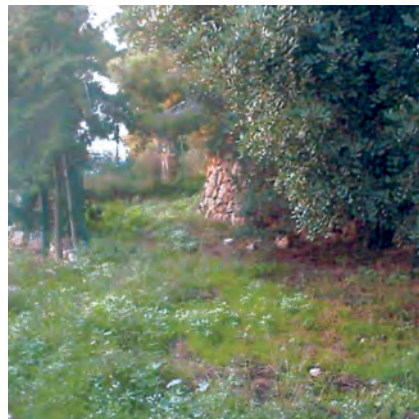
13. Vista parcial del mur de l'extrem oest, presa des del Camí de l'Oliva.
