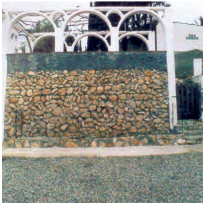
17. Vista parcial del mur cara sud, dins del pati d'una casa habitada.
