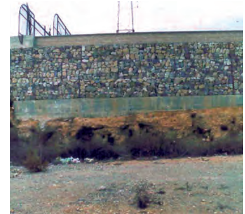
28. Mur reconstruït de contenció del dipòsit d'aigua de l'Oliva.
