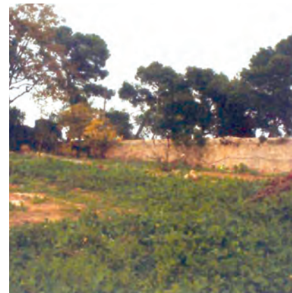
23. Final del mur cara sud sota la Plaça de l'Oliva i, a la dreta, tram de la mina de l'Arquebisbe.
