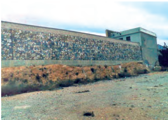
29. Un altra vista del mur anterior, on s'aprecia la roca natural utilitzada com a base de la paret del Fortí.
