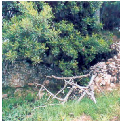
14. Detall del mur de l'extrem oest.
