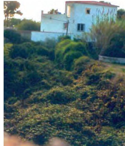
3. Fossat descobert a ponent del vial anterior, amb una longitud aproximada de 40 m. i 9 m. d'amplada.
