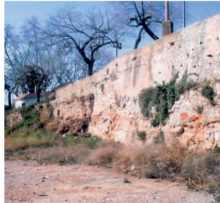
26. Continuació del mur anterior.
