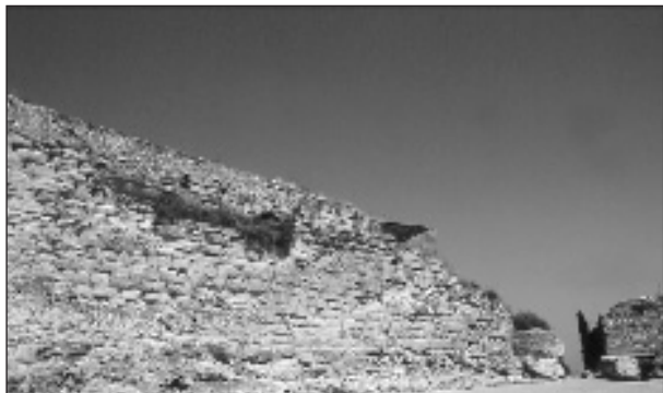
Fig. 28: Plaça de l'Escorxador amb restes d'una portella i evidències d'una possible rampa d'accés al pas de ronda. Foto: Rafael López.
