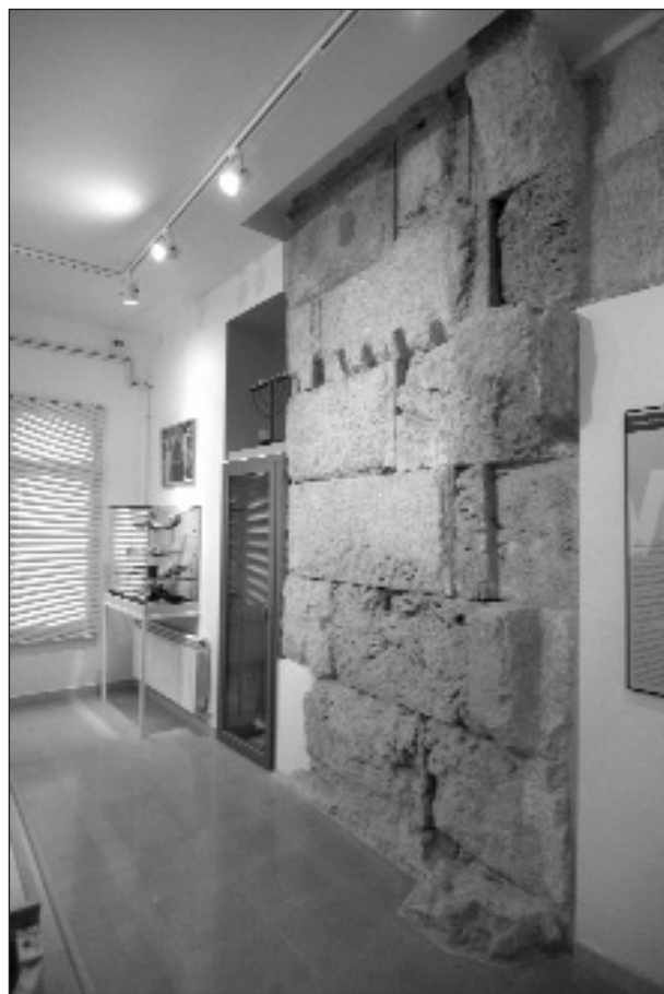
Fig. 32: Tancament oriental del recinte de culte i arrencament d'una de les seves exedres (carrer de les Coques, 1 - carrer Nou del Patriarca, 2). Foto: Joaquim Vendrell.
