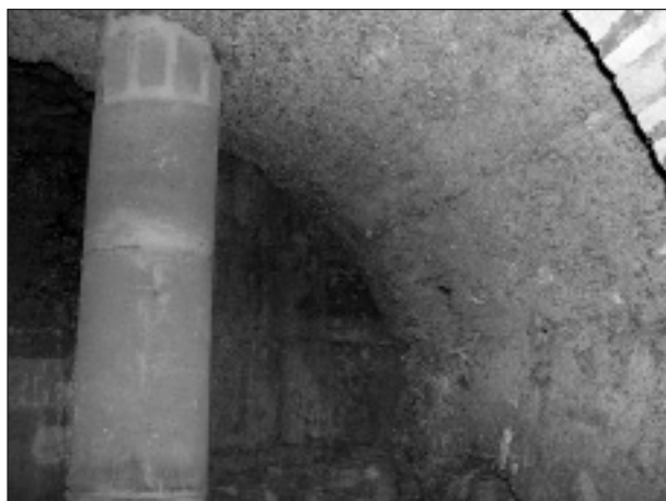
Fig. 61: Volta romana del soterrani dels immobles 7-9 del carrer de Santa Anna. Al fons, el fonament de carreus del mur de fons del porticat. Als peus de la imatge, la part superior d'un dels nínxols dels estreps de la volta. Foto: M. T. Miró.
